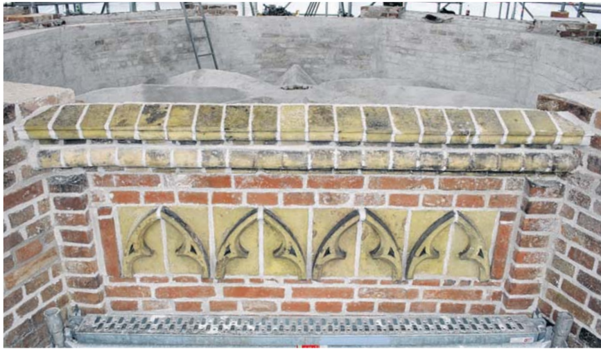
Sogenannte Nonnenköpfe zieren das Mauerwerk unterhalb des Ringankers. Das Dach wird später wieder aufgesetzt.
