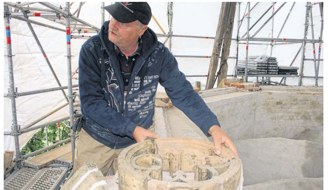
Annegret Stein vom Förderverein (oben) zeigt den Formstein, der einem Nonnenkopf ähnelt und darum auch so heißt. Gegen eine Spende für die Sanierung der Jahn-Kapelle können die angeschlagenen Steine erworben werden. Volker Berner (unten) bessert das Mauerwerk rund um das Dachgewölbe aus. Es ist mit vielen verschiedenen Formsteinen versehen. FOTOS: HEIKE SOMMER
