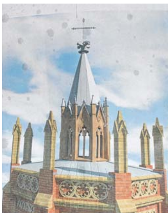
In der ersten Bauphase wird das Dach der Kapelle saniert. Auf der Zeichnung kann man schon sehen wie es dann aussieht.
