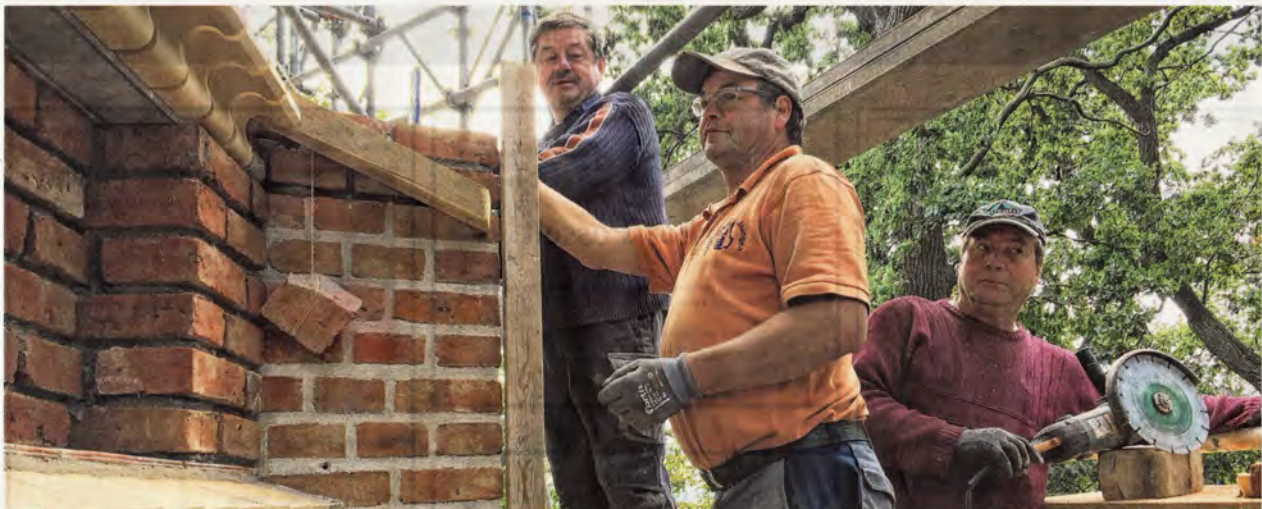
Gewölbe, Schmucktürme und Gesims müssen an der Kapelle mit alten und neuen Formsteinen aufgemauert oder ausgebessert werden. Joachim Wendel, Jörg Werdermann und Jörg Jamm sind Experten, was diese Arbeiten betrifft. Sie haben schon an vielen Kirchen gearbeitet. FOTOS ©: HEIKE SOMMER
