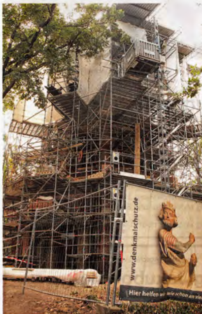
Hinter diesem futuristisch anmutenden Gerüst wird die Jahn-Kapelle restauriert.
