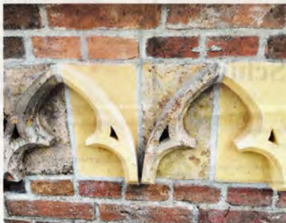
Alte und neue Formsteine werden bei der Sanierung der Kapelle Klein Vielen verwendet.
