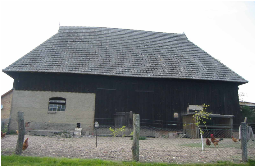
Querdielenscheune in Hartwigsdorf mit Walm und regionaltypischer Verbretterung
