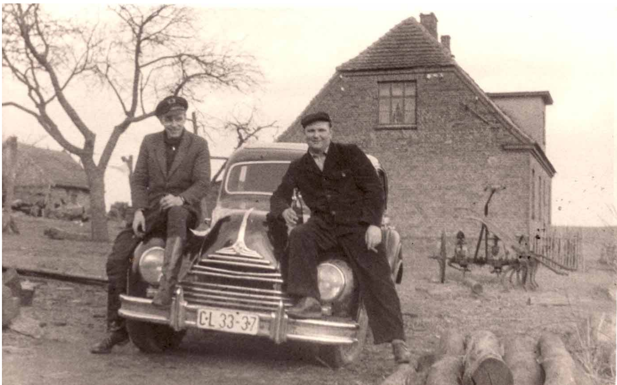
Jennyhof, Gebäude Nr. 4 im Übersichtsplan, Schnitterkaserne, Westseite, Dach mit Krüppelwalm, Giebel- fenster und Gaube zu eingebautem Zimmer im Dachgeschoss. Rechts: Ernst Mahnke. Quelle: Archiv Werner Dunker
