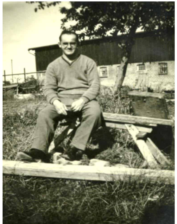
Paul Deilmann (während des Krieges in Jennyhof) vor Haus Nr. 6 (Kuhstall) im Übersichtsplan, das nach 1945 für die Familien Ritter und Knubbe ausgebaut wurde. Quelle: Archiv Familie Swolinski
