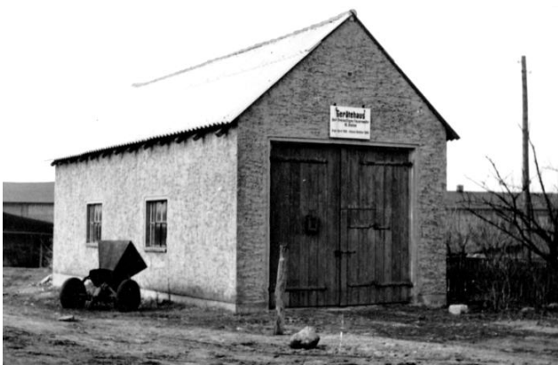
Ehemaliges Gerätehaus der Freiwilligen Feuerwehr Klein Vielen.
