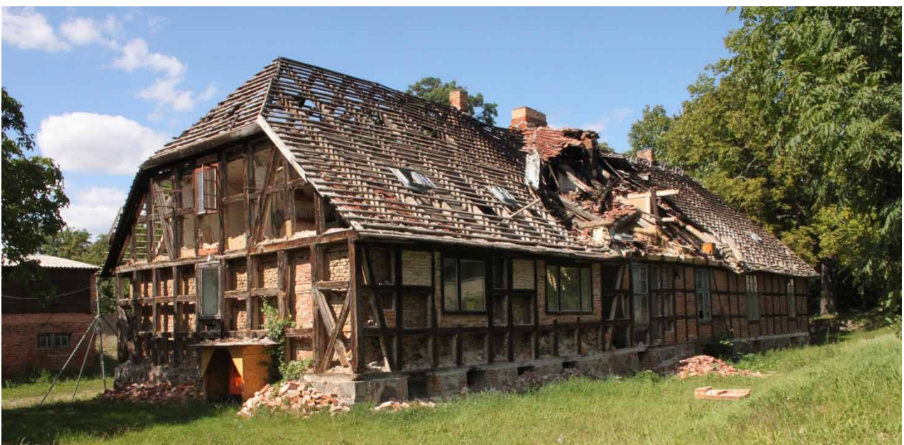
Das „Wirtschaftshaus“ des ehemaligen Maltzanschen Gutes Peckatel im August 2013. Foto: H. Behrens
