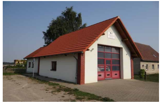
Heute: Gerätehaus mit Aufenthaltsraum der Freiwilligen Feuerwehr der Gemeinde Klein Vielen.
