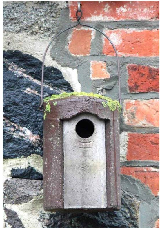
Starenkasten aus Holzbeton. Dieser Kasten ist bereits 41 Jahre alt.
