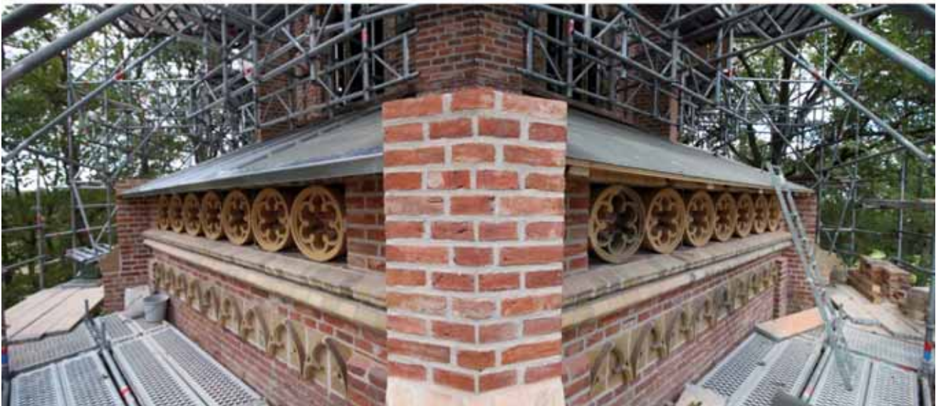
Attika und Dächer der Seitenschiffe im Restaurierungsfortschritt.
