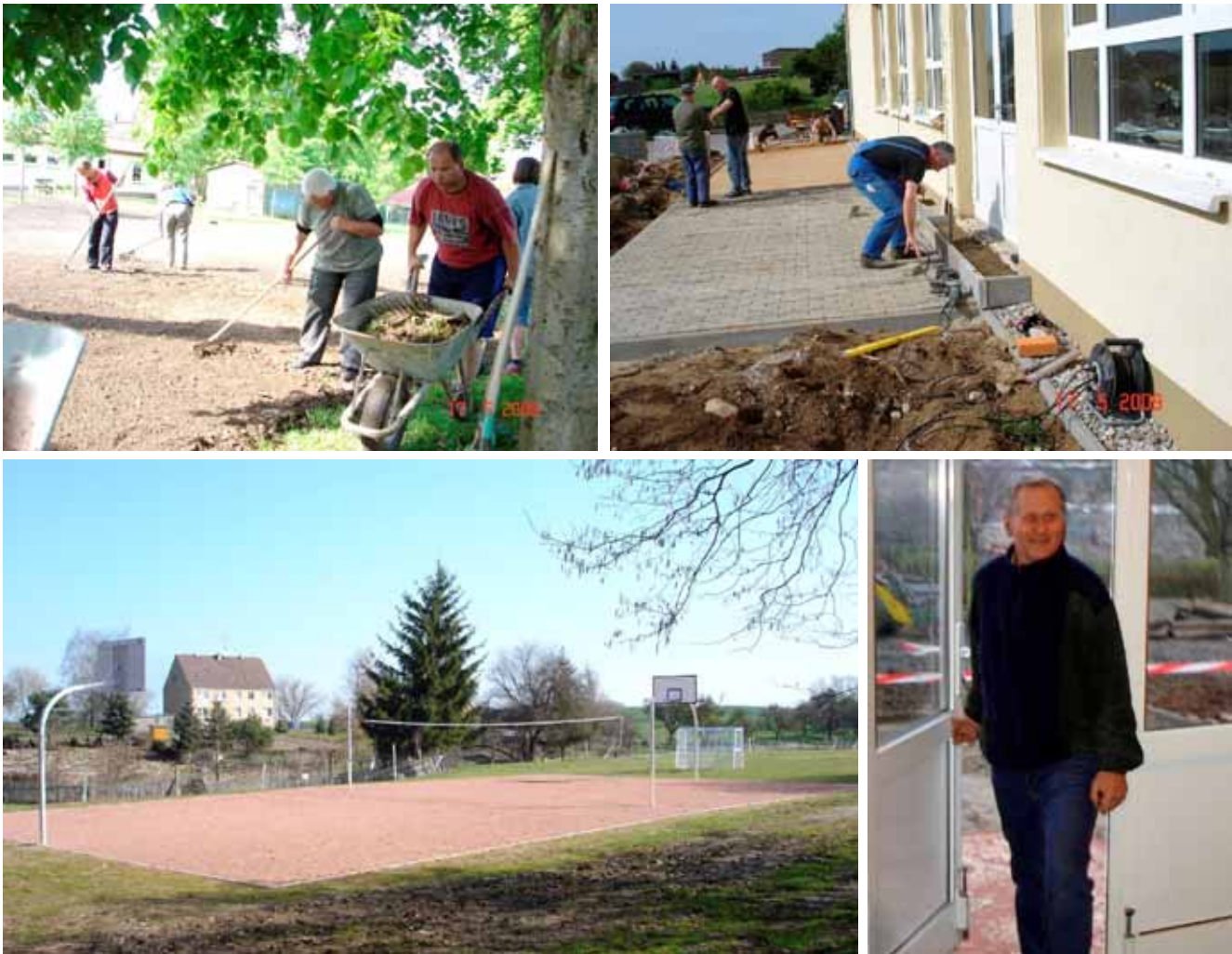
Fotos oben: Gestaltung der Außenanlagen durch freiwillige Helferinnen und Helfer. Foto unten links: Das Basket- und Volleyballfeld. Foto rechts: Der ehemalige Hausmeister Bodo Vonhoff.
