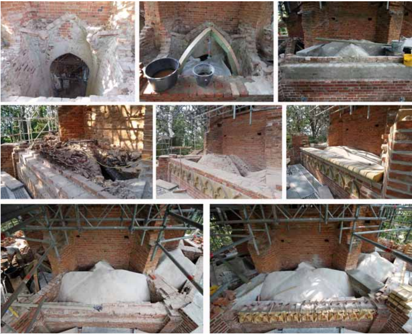
Restaurierung der Kreuzgewölbe über den Seitenschiffen.
