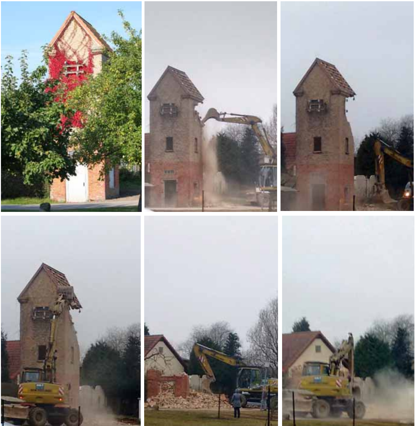
Abriss des Trafohäuschens in Peckatel 2018. Fotos: H. Behrens.
