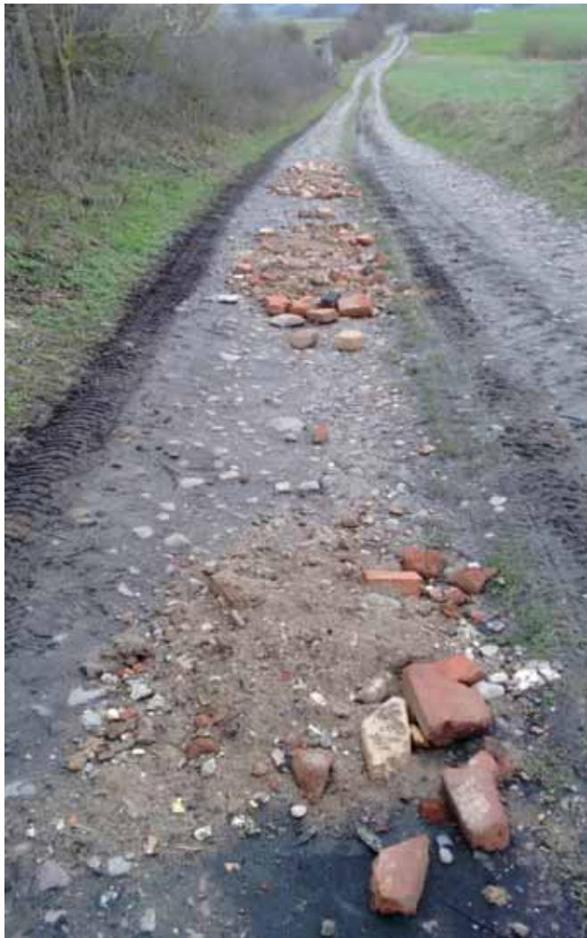
Vermüllung des Jennyhöfer Weges mit Bauschutt, 2019. Foto: H. Behrens.
