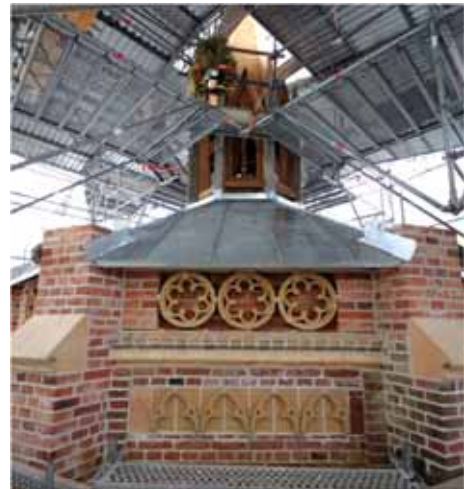
Kreuzblume nach dem Einbau und Turmgeschoss, März 2018.
