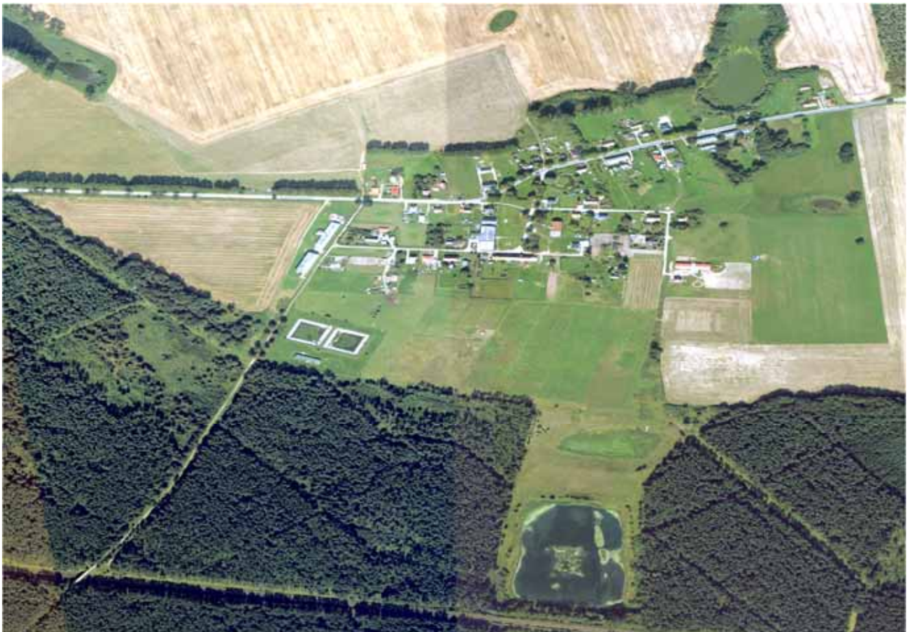
Verlauf des ehemaligen Wanderweges über die Eisenbahnbrücke Adamsdorf (linke Bildhälfte) sowie Speicherbecken zwischen Dorf und Waldrand. Foto: Archiv Martin Kaiser.
