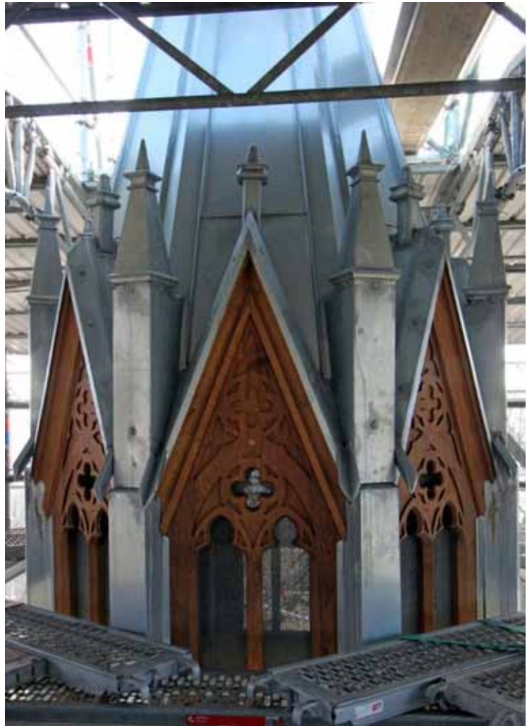
Die Fialspitzen an der Laterne nach der Montage.
