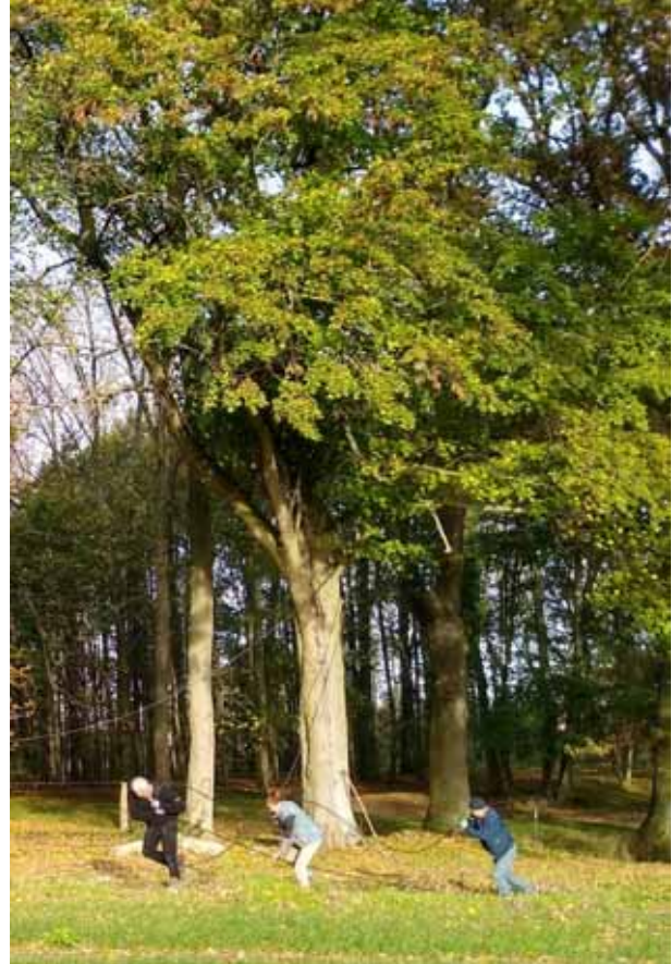
Freiwillige helfen bei der Verlegung des Stromkabels. Foto: Behrens.
