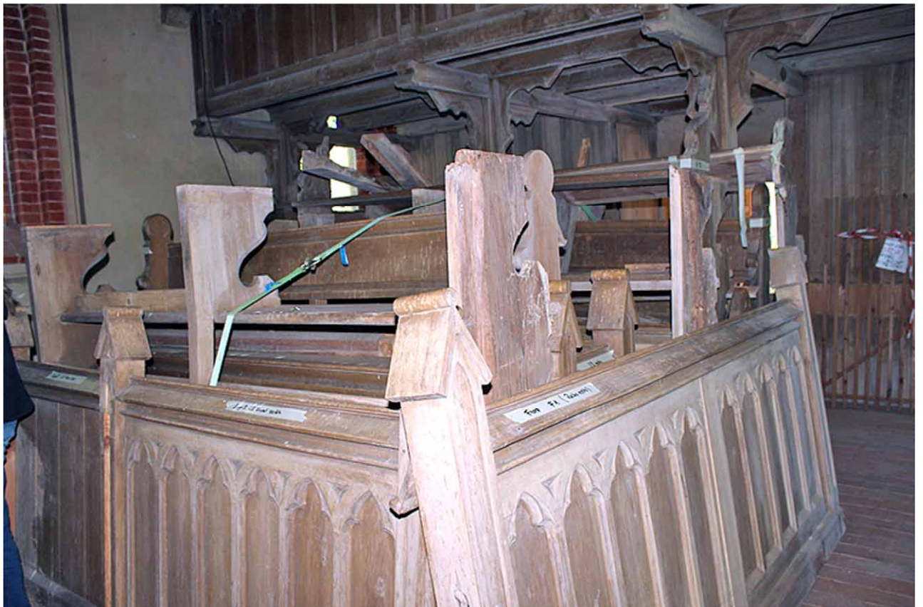
Baustelle Liepener Kirche. Fotos: Hans-Jürgen Wolf. Auch ein Stromkabel wurde verlegt.
