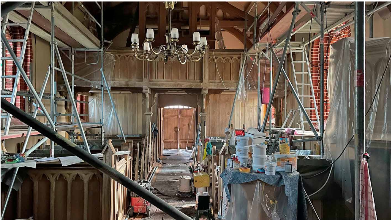
Das Innere der Kirche in Liepen – eine große Baustelle. Foto: Torsten Benzin.
