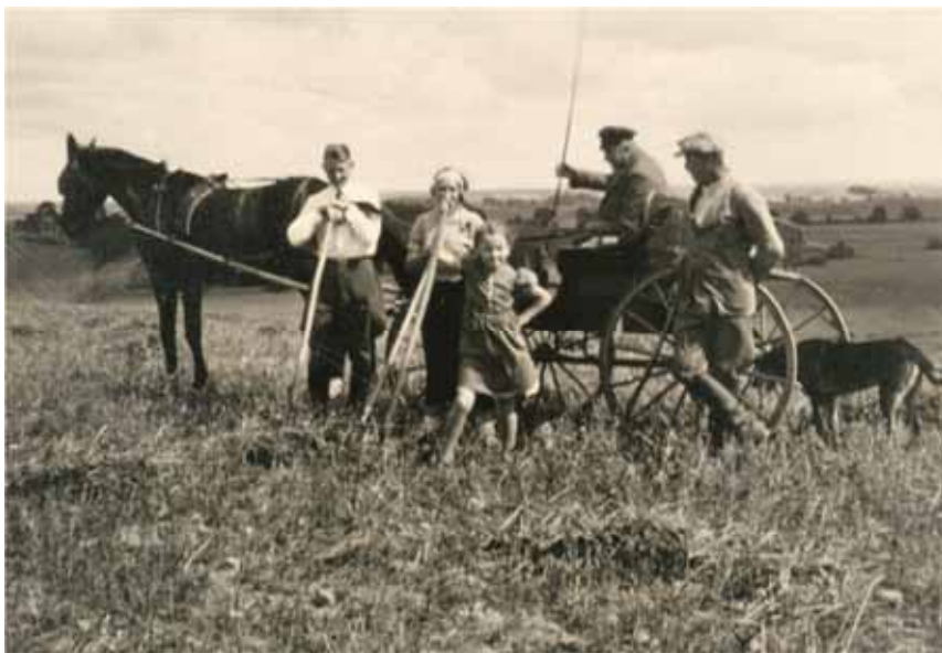
Herbert Benkendorff mit Arbeitern beim Düngerfahren.
