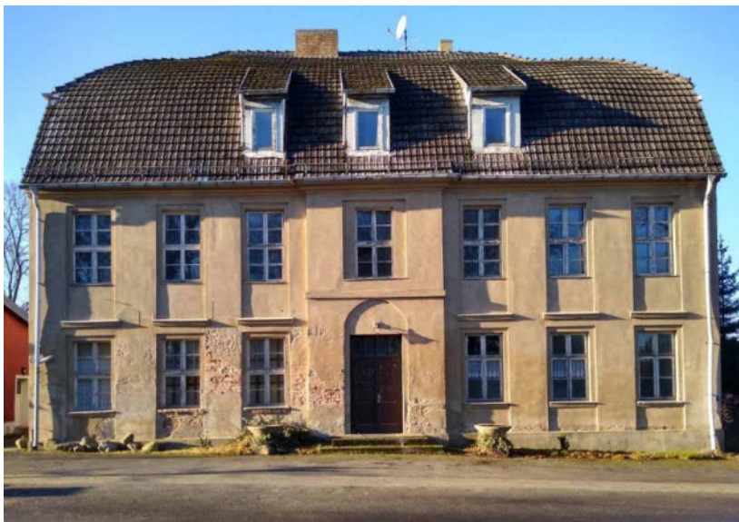
Das Kruggebäude in Hohenzieritz 2021. Foto: H. Behrens.
