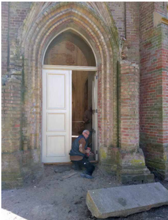
Jürgen Krämer beim Einbau der Kapellentür; vorne: der Granitstein für die Türschwelle. Foto: H. Behrens.
