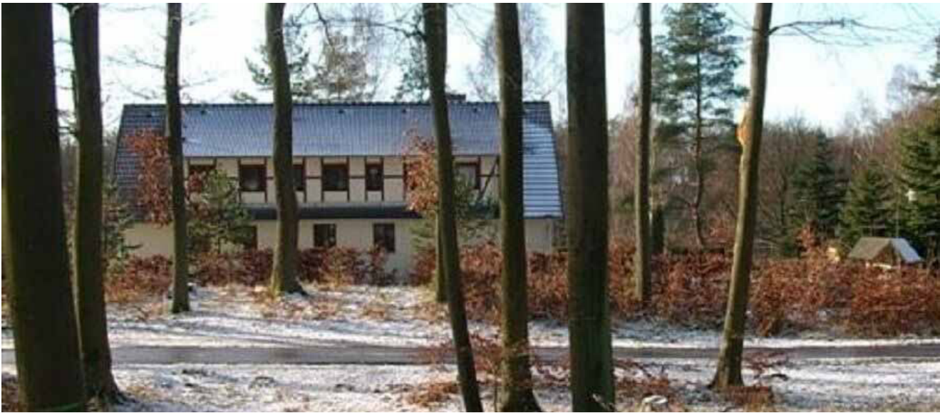
Abb. 9: Das Gebäude dient heute weiterhin als Forstamt.
