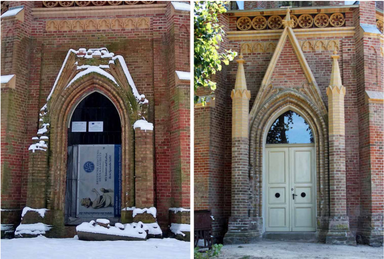
Das Portal vor und nach der Sanierung. Fotos: H. Behrens.
