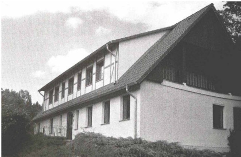
Abb. 8: 1992 wurde dieses Gebäude der ehemaligen Staatsjagd zum Forstamt Wilhelminenhof.
