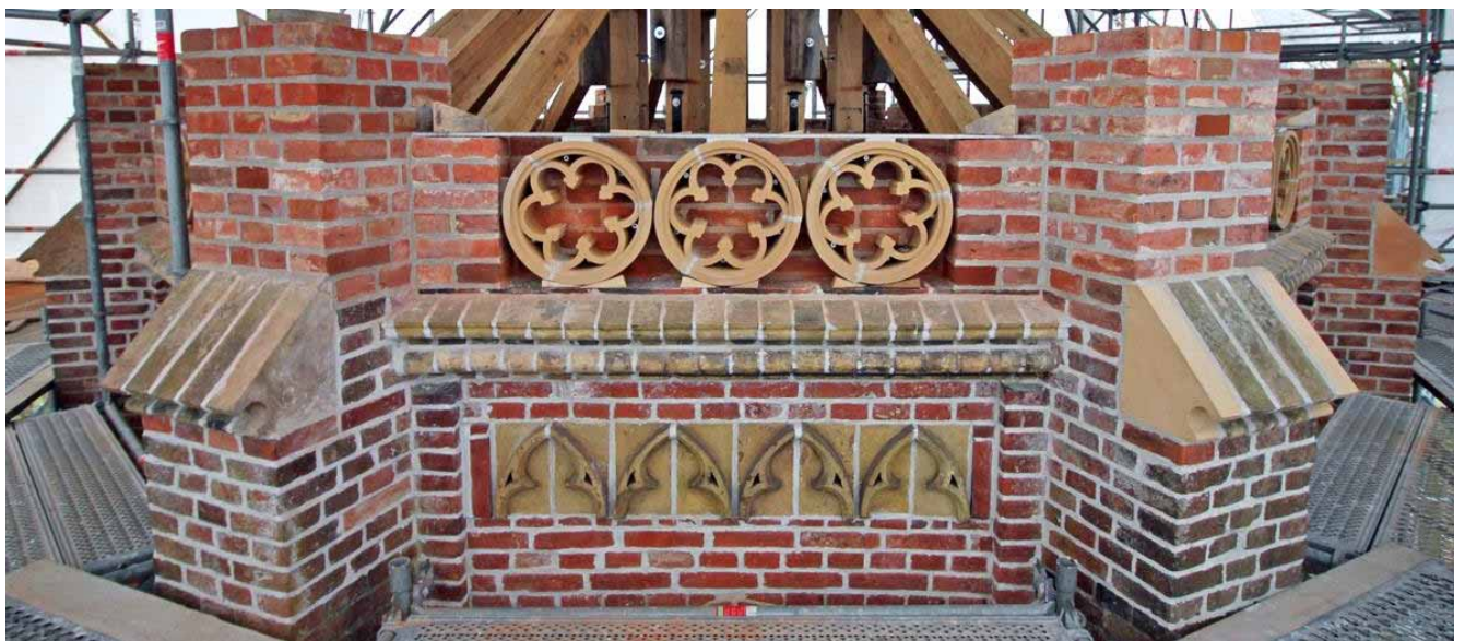
Die bis auf die Mauerkrone wiederhergestellte Attika mit der Sechspass-Verzierung.
