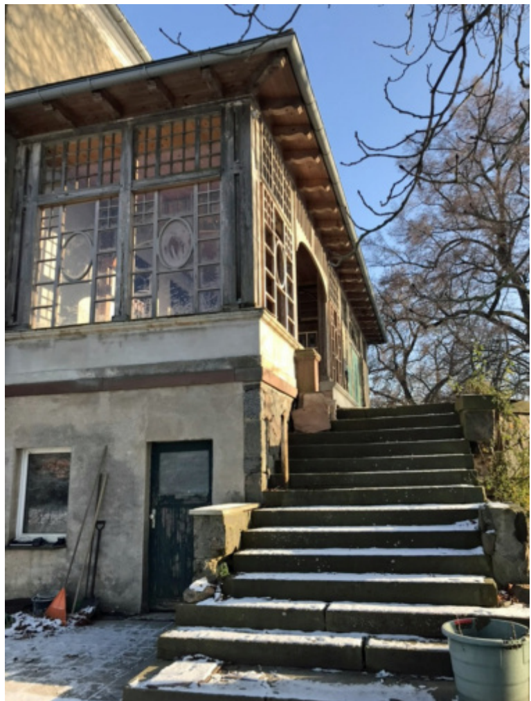
Abb. 11: Heutiger Zustand der Veranda.
