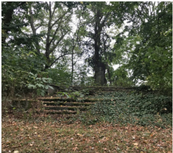
Abb. 15: Heutiger Zustand der Anlage.
